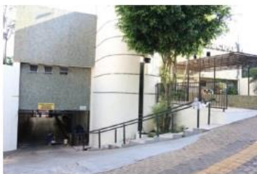
As obras começaram na semana passada e incluem instalação de rampa de acesso no plenário
