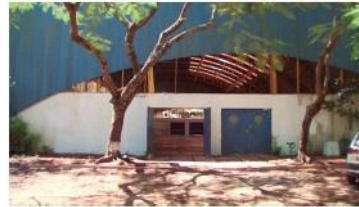
Prédio que estava cedido ao Corpo de Bombeiros poderá ser repassado à Academia Policial Militar do Guatupê
