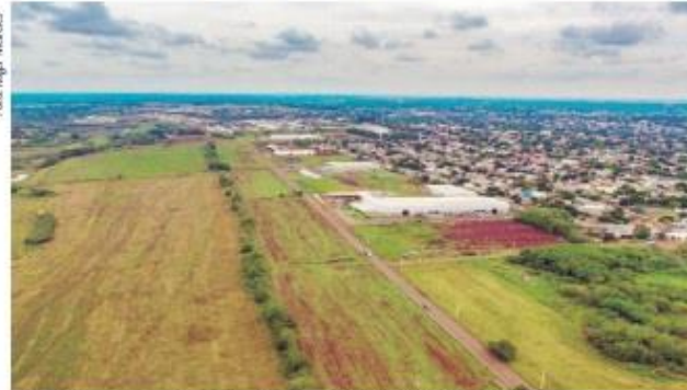
Obras de drenagem serão realizadas na região do Distrito Industrial
